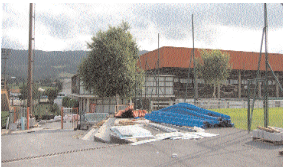
Hasiak dira instalazioen berrikuntzak
